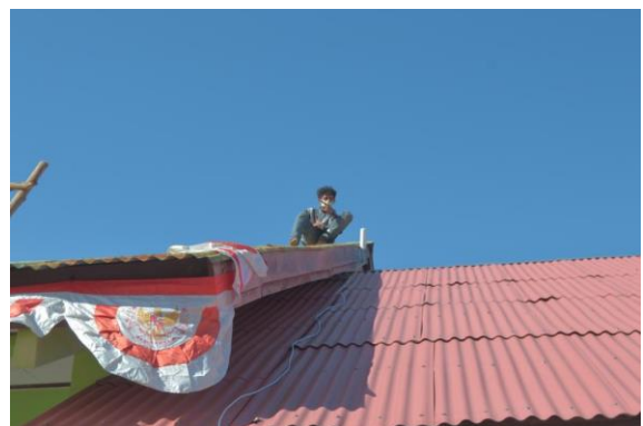
Gambar 4. Pemasangan Antena penerima sinyal GSM di atas atap sekolah.
