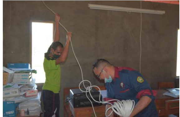
Gambar 3. Pemasangan kabel Antena penerima sinyal GSM ke receiver.
